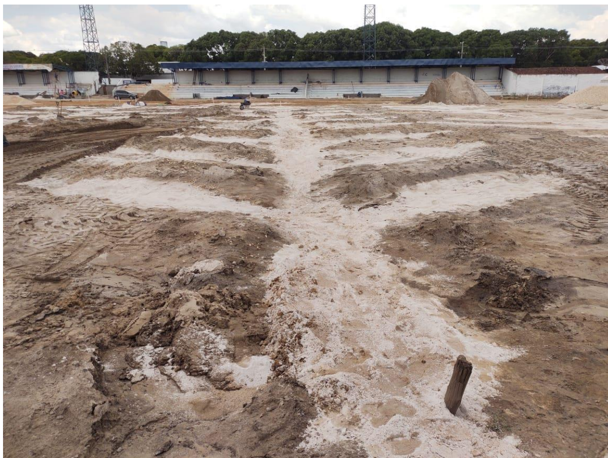
Foto 05: Reforma e revitalização do Estádio Maximino Porpino Filho, no município de Castanhal/PA (Região Guamá).
